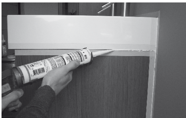
3. Afkitten langs wastafel, onderkast en wand
