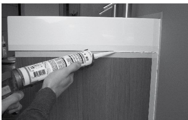
3. Afkitten tussen wastafel, onderkast en wand
