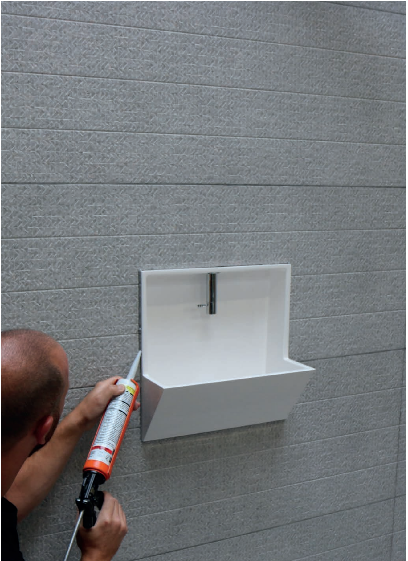
Na kan de echte afwerking beginnen. Na het aanbrengen van de tegels oid kan het fontein rondom worden afgekit. Now the real finish can begin. After applying the tiles or other finish, the hand washbasin can be sealed around with silicone kit.
