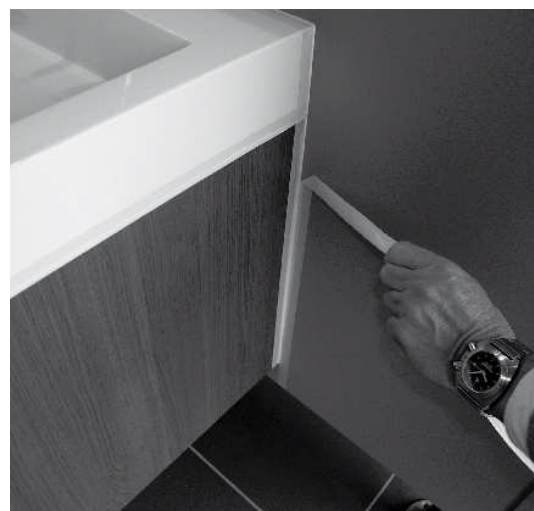
D. Schilderstape direct na gladstrijken verwijderen en de kitnaad nog 1 maal nastrijken
